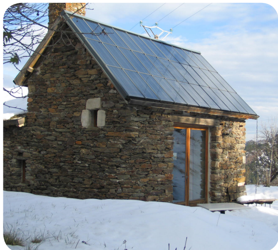
Panneaux solaires thermiques à La Combe de Ferrière.
